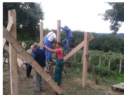
Gradnja drvene sjenice za prihvat gostiju
